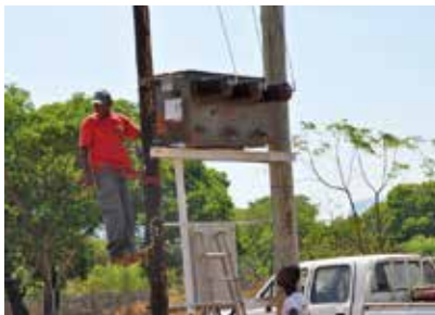
Installation d'un transformateur électrique pour connecter l'école de Mecubùri au réseau électrique national
