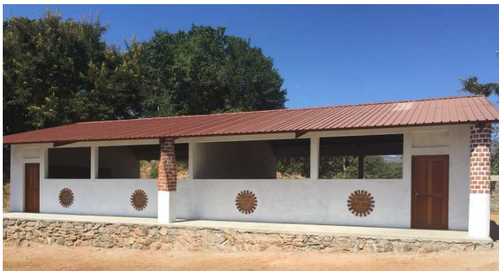
L'école de maçonnerie de Malema, vitrine du savoir-faire transmis par les assistants techniques
